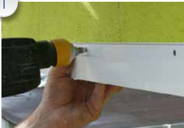
Colocación del perfil de base (o del recuperador)
