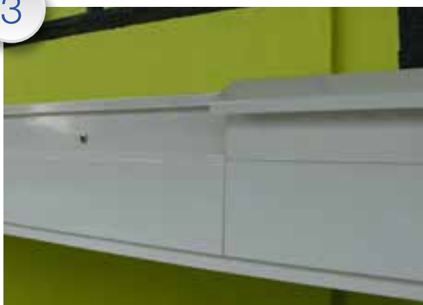
Colocación de perfil protector
